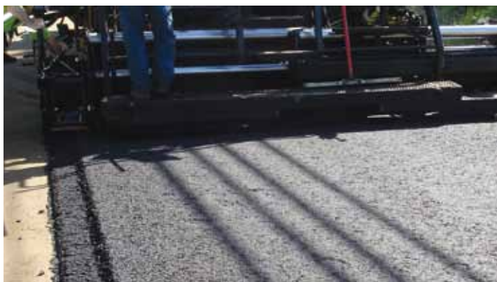
摊铺机正在摊铺的缺口楔面接缝。
