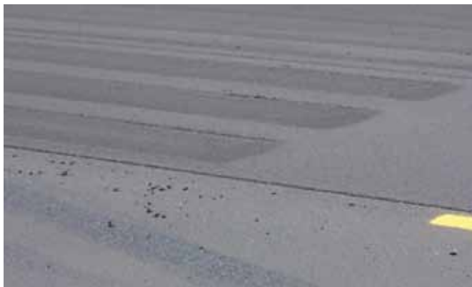
轮胎压路机留下的轮胎痕迹通常可以被终压阶段压路机清除。
