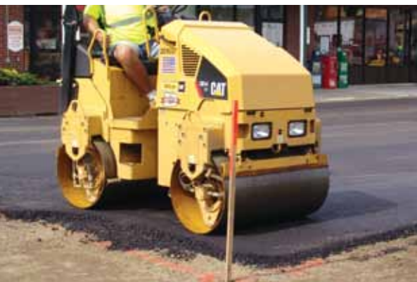
多功能压路机更容易围绕障碍物进行压实，而不会使新沥青出现裂缝。
