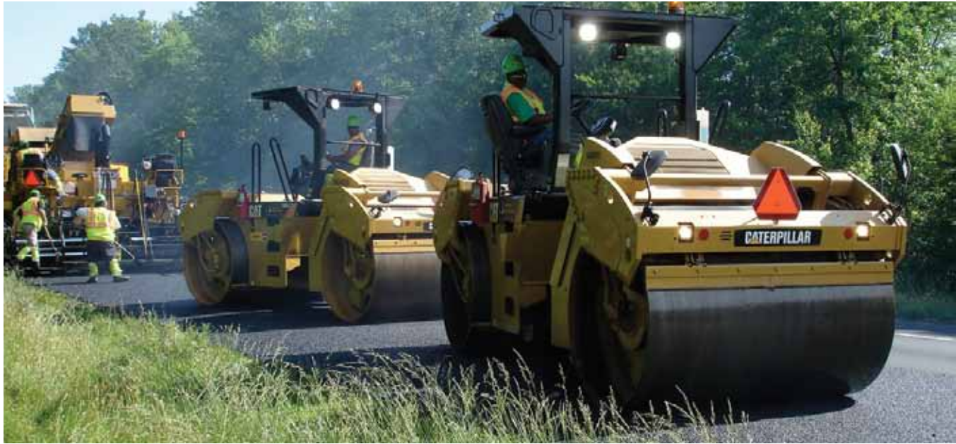
摊铺机后方倒退的两台初压压路机。注意停止时成一定角度。
