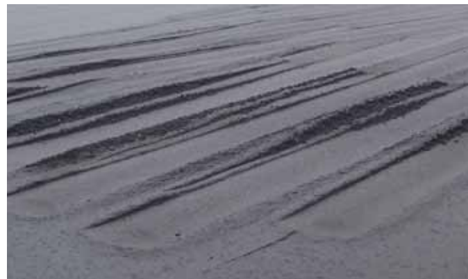
在含有软质混合料的厚层面上运行会产生难以清除的深轮胎痕迹。
