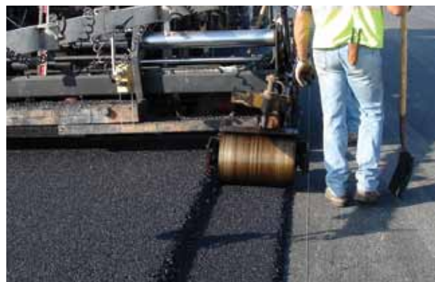
拖式压路机可用于缺口楔面接缝。
