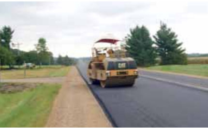
驻车时,使机器部分位于路肩上。
