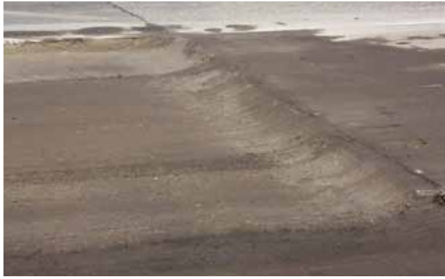
较差的起始参照示例。较深入形成的弧形断面会影响压实。
