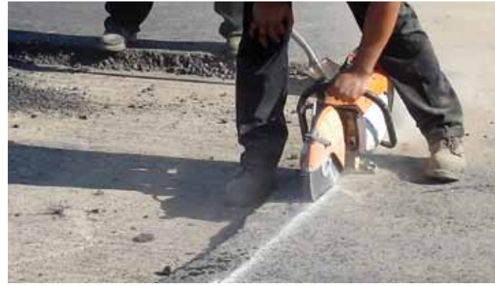
要求在横向接缝处切割或铣刨出一个垂直断面。
