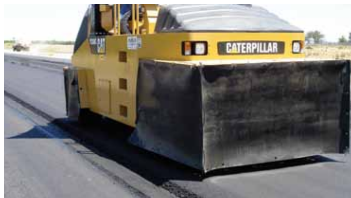
轮胎压路机应始终与无侧限边缘保持至少 15 cm (6") 的距离。
