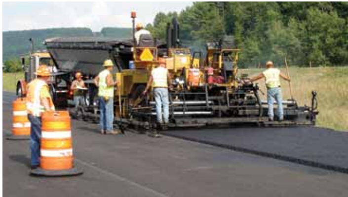
使熨平板侧板采用浮动位置在摊铺的纵坡上运行，形成垂直无侧限边缘。
