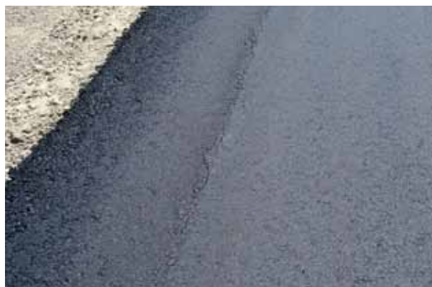
钢轮的边缘与无侧限边缘之间有一定距离时，铺层上沿钢轮的边缘出现的裂纹。
