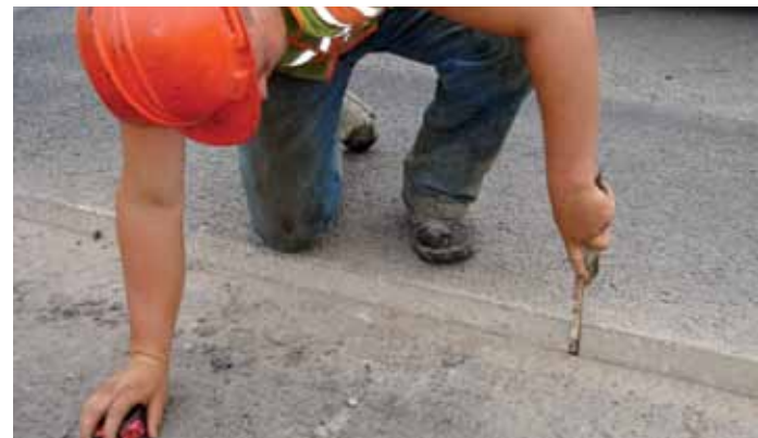
检查起始接缝的厚度可帮助工作人员选择正确的起动垫板厚度。
