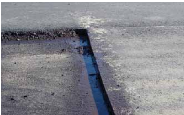
在开始摊铺前已经施涂胶黏剂的良好锯切接缝示例。
