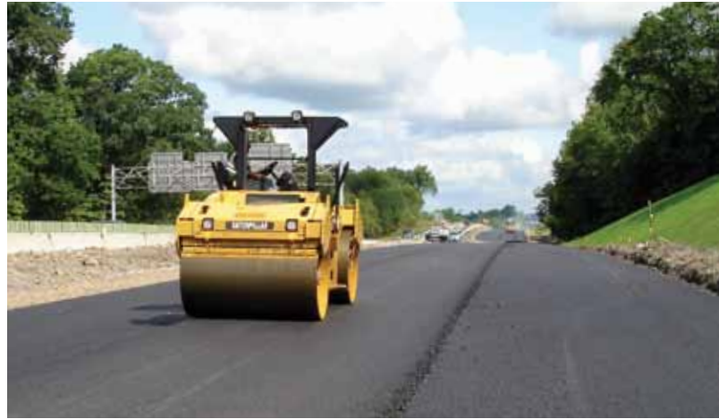
终压阶段通常使用以静态模式操作的双钢轮压路机。
