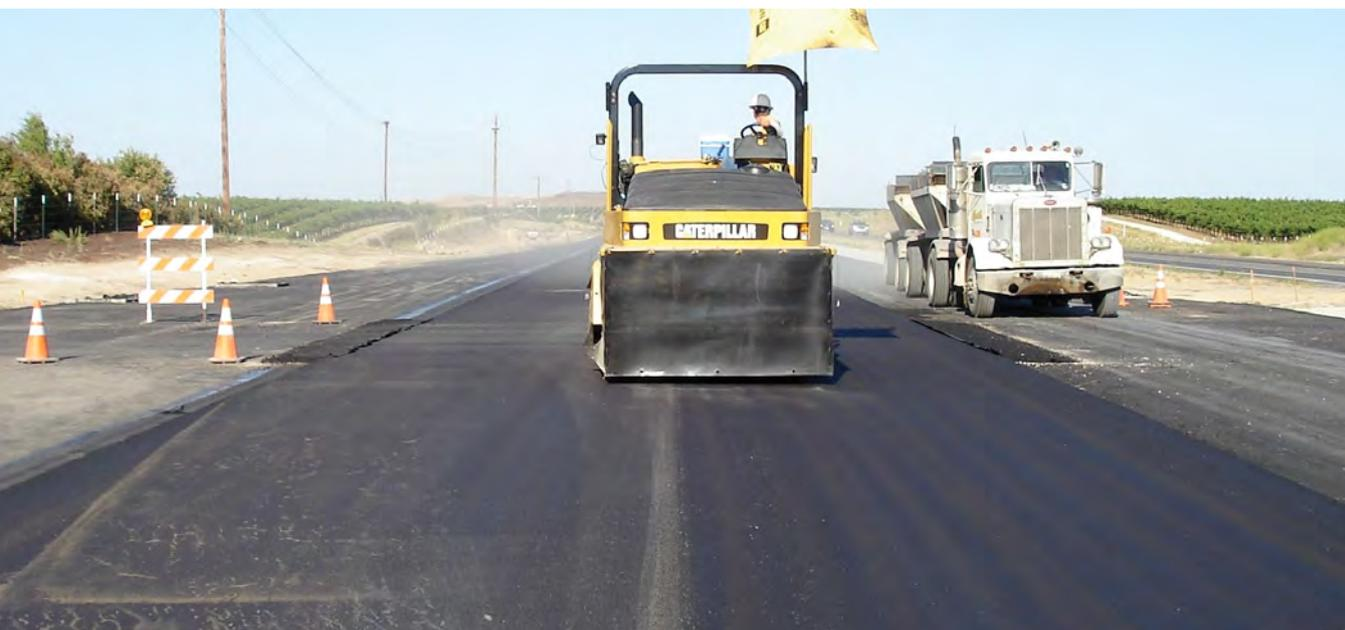
*El compactador neumático sella la junta longitudinal caliente / fría.*
