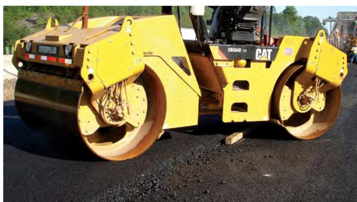
*Compactador estacionado sobre el acotamiento durante el llenado de los depósitos de agua (izquierda) para evitar marcar la carpeta en el carril de tráfico. Si es necesario, se debe proporcionar una manera para que el compactador pueda salir de la carpeta que no tiene borde confinado.*
