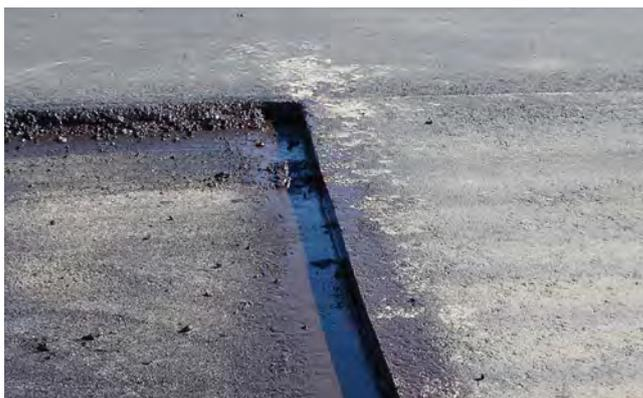
*Ejemplo de una junta cortada correctamente con sierra, se recubrió con una carpeta de ligante antes de iniciar la pavimentación*
