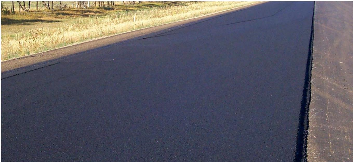
*Tener una orilla recta donde pegar la junta es esencial en una junta longitudinal.*
