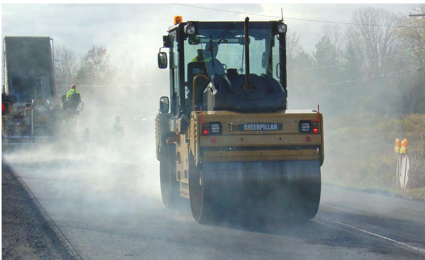
*Una operación consistente de la máquina pavimentadora y el compactador de la fase inicial son clave para lograr una densidad consistente.*
