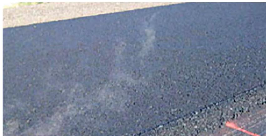
*Variación en la temperatura causada por una parada de más de 10 minutos de la máquina pavimentadora. La impresión de la plancha que se ve en la imagen infrarroja no es visible en la imagen digital.*
