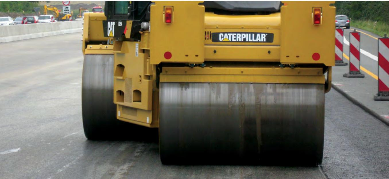
La capacidad de desplazar el rodillo facilita una cobertura más ancha para una compactación más rápida en carpetas delgadas que pierden rápidamente el calor.
