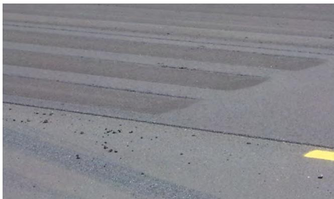
*Las marcas de neumáticos dejadas por un compactador de neumáticos normalmente se pueden limpiar con el compactador de la fase final.*
