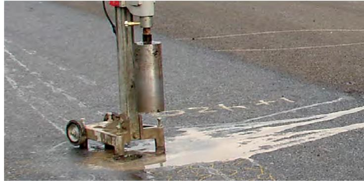
*El corte de núcleos y análisis de laboratorio darán la confirmación final que la densidad de la franja de prueba cumple con los requerimientos deseados.*
