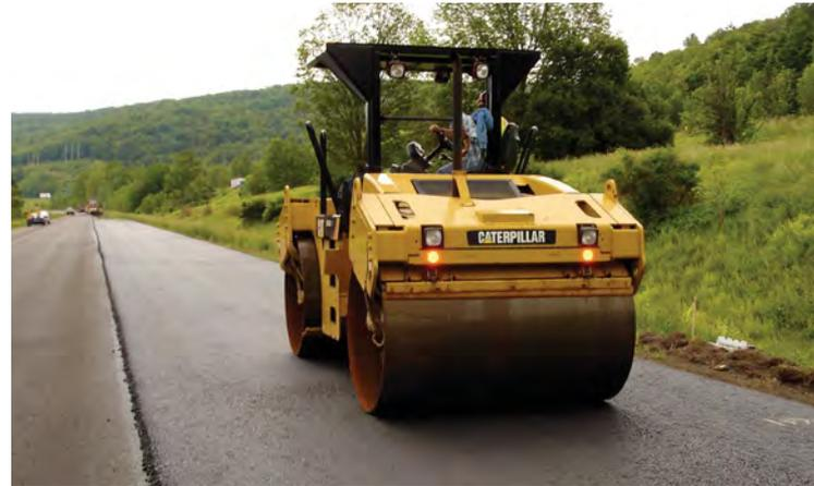
*Los compactadores vibradores que se usan en la fase intermedia se ajustan en una amplitud baja.*
