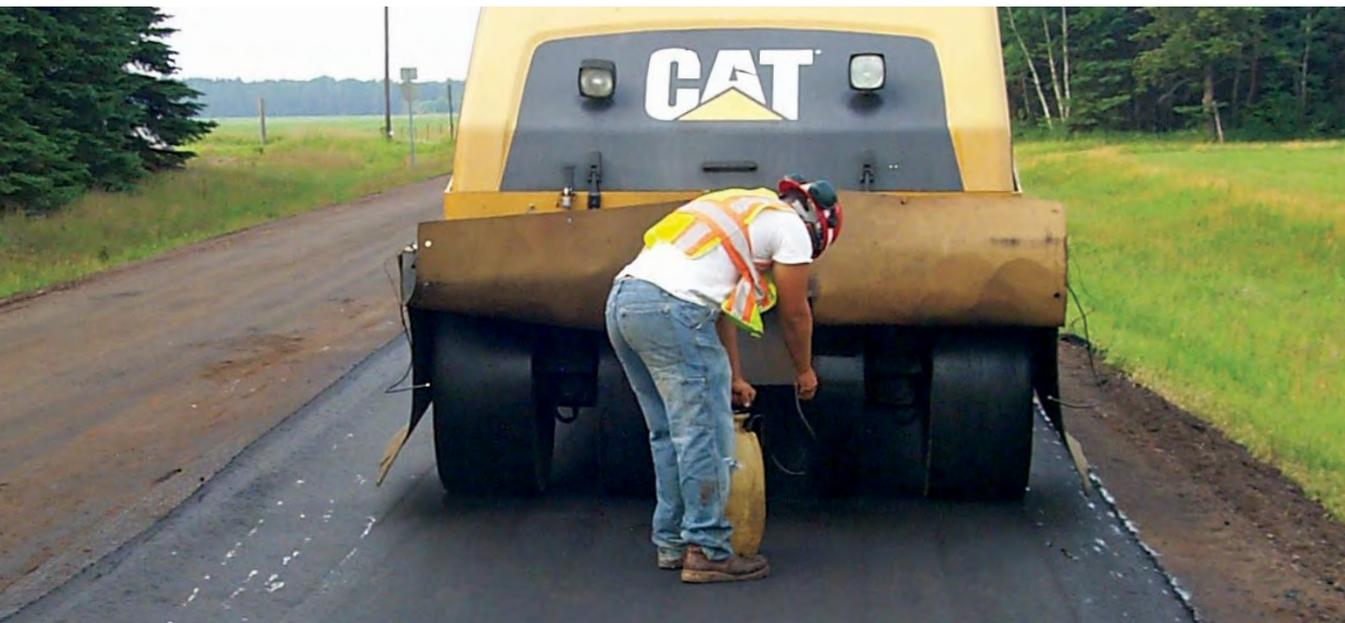
*Los agentes removedores se pueden aplicar utilizando un aspersor o el sistema de aspersión para neumáticos del compactador.*
