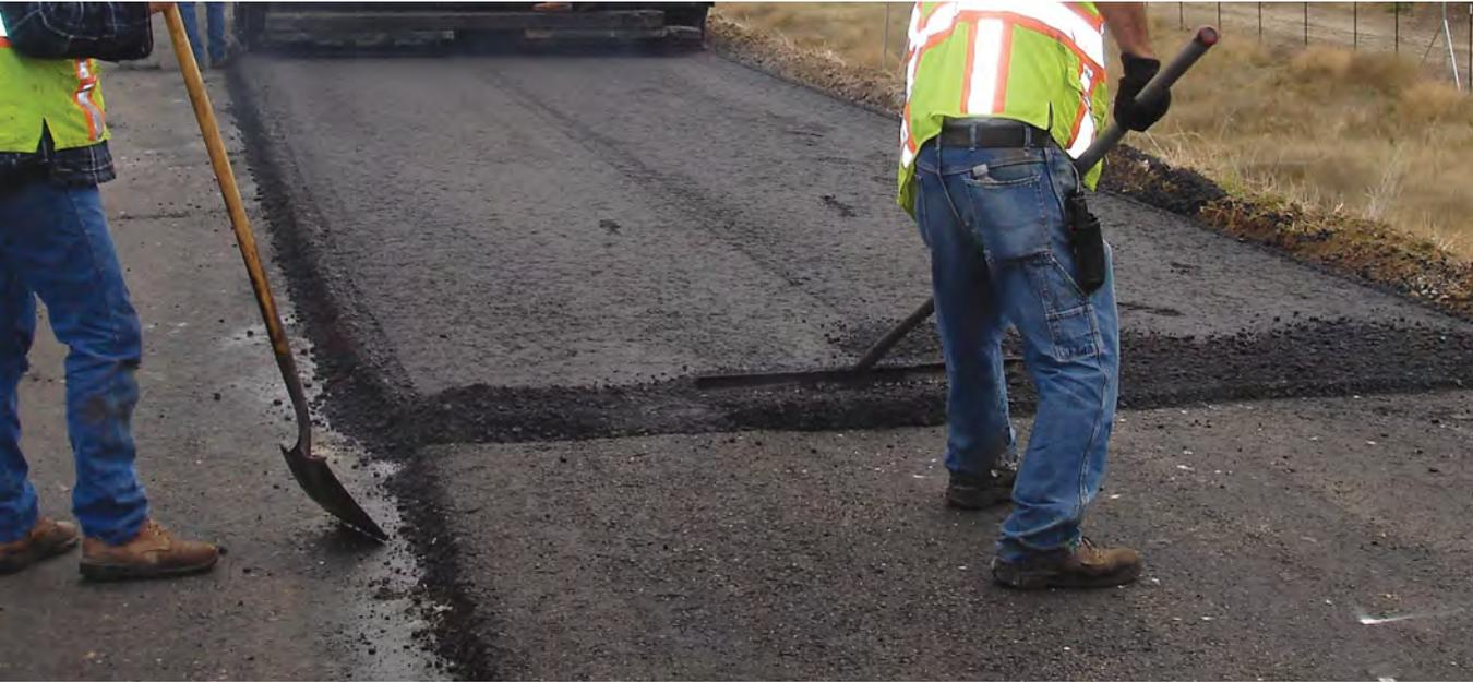
*Una vez que se retira la pavimentadora se debe hacer el trabajo manual de la junta transversal de inicio.*
