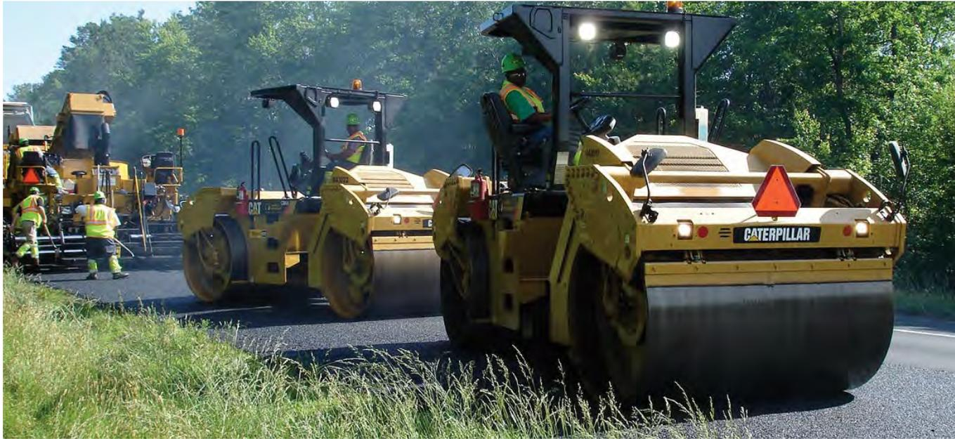
*Dos compactadores de fase inicial dando reversa detrás de la pavimentadora. Realizan una parada en ángulo.*
