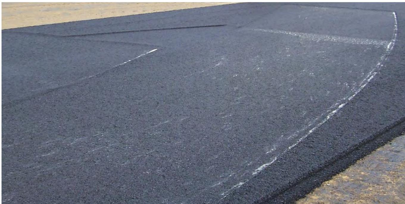
*Si se hacen paradas repetidas para dar reversa por la misma área se sobrecargará el asfalto fresco.*
