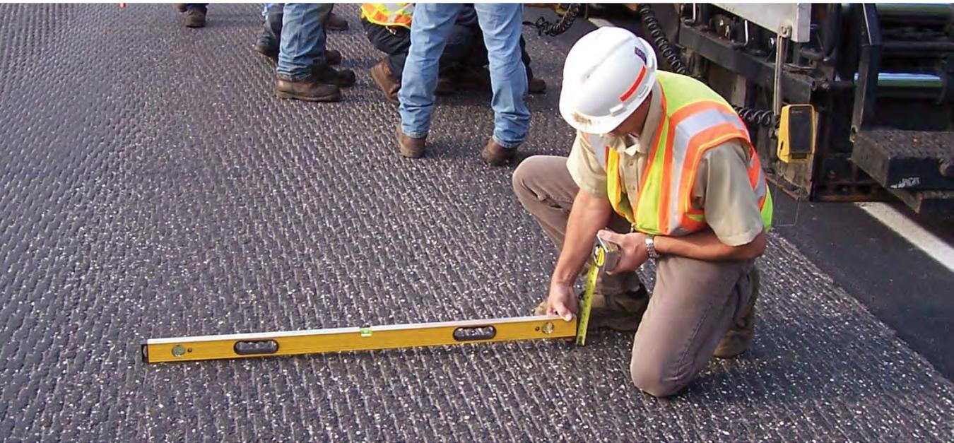
*El grosor de la carpeta puede ser variable cuando la cuadrilla de pavimentación utiliza el control de pendiente.*
