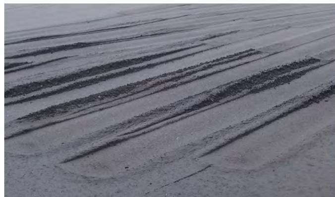
*Las marcas profundas de los neumáticos creadas cuando se opera sobre una carpeta gruesa compuesta de una mezcla sensible son difíciles de limpiar.*
