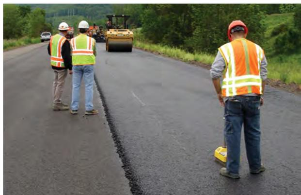
*La compactación del asfalto se inicia con la plancha regla pavimentadora y se termina con los compactadores de rodillos trabajando inmediatamente detrás de la pavimentadora. Los miembros de la cuadrilla con frecuencia vigilan el proceso de compactación.*
