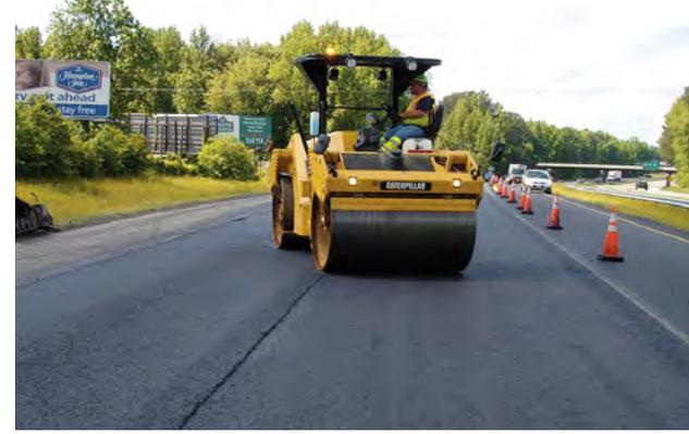
*Cuando el compactador puede rodar hasta una carpeta asfáltica compactada y fría se evita dejar marcas de la parada de los tambores en la carpeta asfáltica fresca.*
