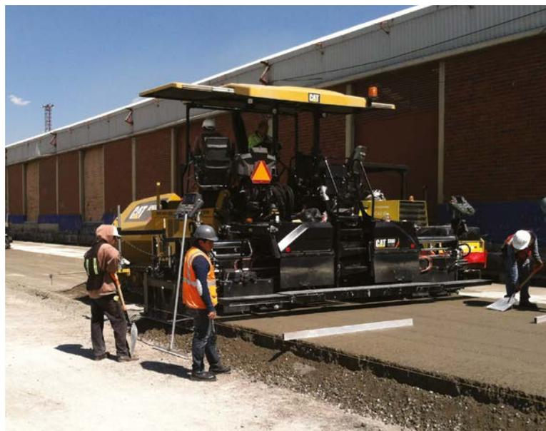
Use el sistema de contrapeso de la regla para ayudar a la regla a que flote adecuadamente cuando aplica capas gruesas de concreto compactado con rodillo.
