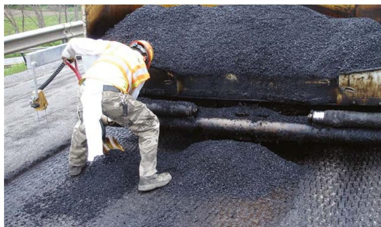
*Los derrames en el suelo delante de la pavimentadora constituyen un gran error y deben corregirse.*
