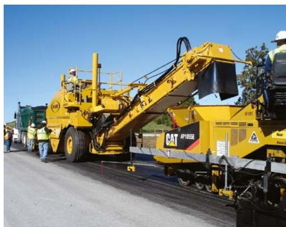
La mezcla de material por parte del vehículo de traslado de material mejora el control de segregación, la uniformidad y la temperatura de la capa.
