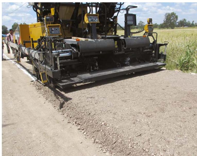
*Regla combinada de 2,5 m (8') aplicando una base de agregados de 3,5 m (11,5') de ancho y 30 cm (12") de profundidad.*
