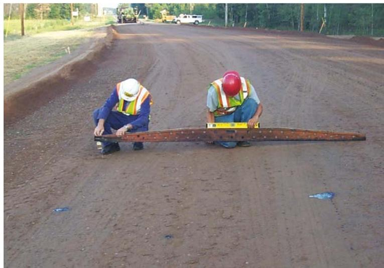
*Verifique las inclinaciones transversales en toda la longitud de la curva de la superelevación.*
