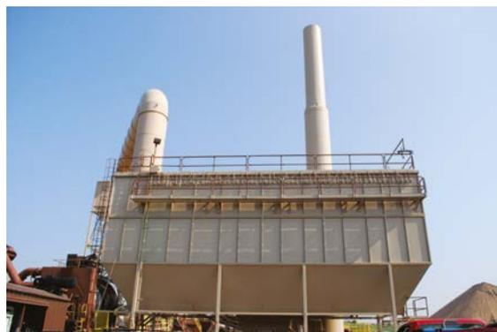
*El polvo seco recolectado por una cámara de filtro de sacos tiene la posibilidad de regresar a la mezcla.*
