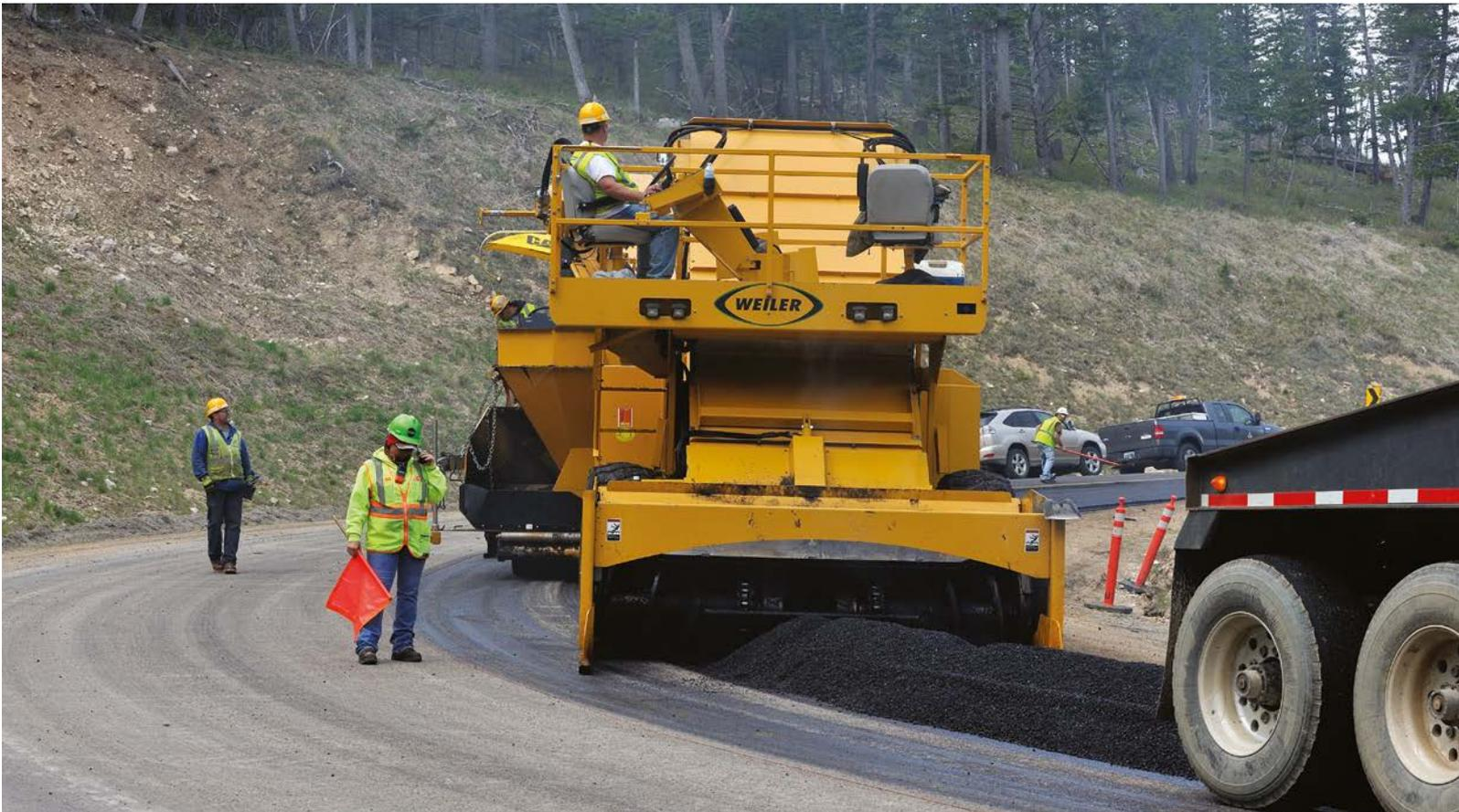
*Los dispositivos de traslado de material, este equipado con un cabezal de elevación de hilera, permiten a la pavimentadora funcionar continuamente a la misma velocidad.*
