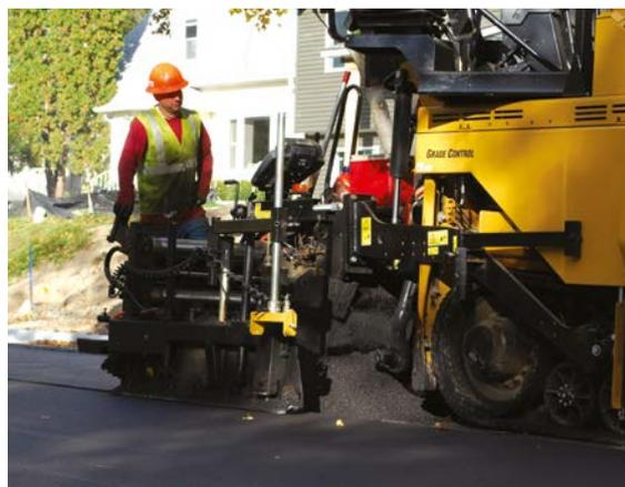
*Generalmente se usa un sensor individual para equiparar la altura en una junta longitudinal en playas de estacionamiento y calles.*
