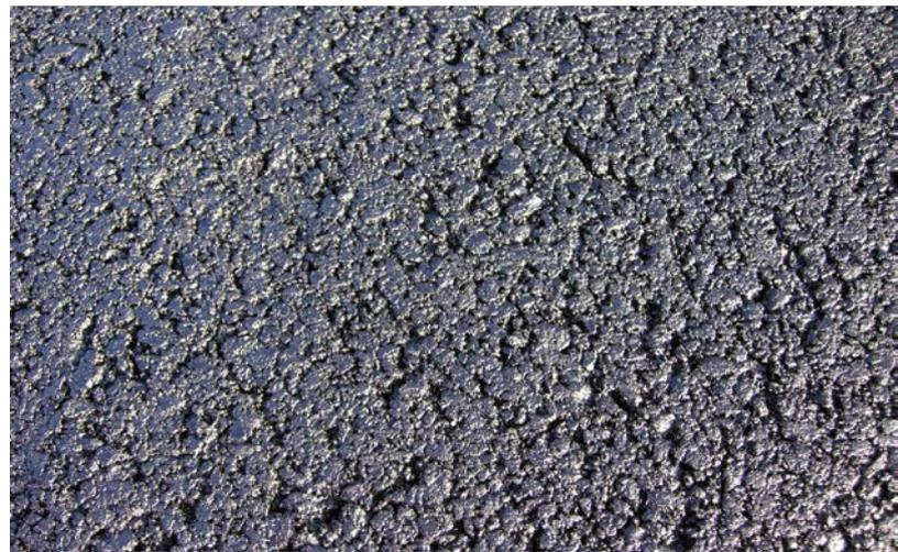
Las capas de mezclas de granulometría abierta pierden calor rápidamente por lo que la velocidad de pavimentación debe coincidir con la velocidad del rodillo de desintegración.
