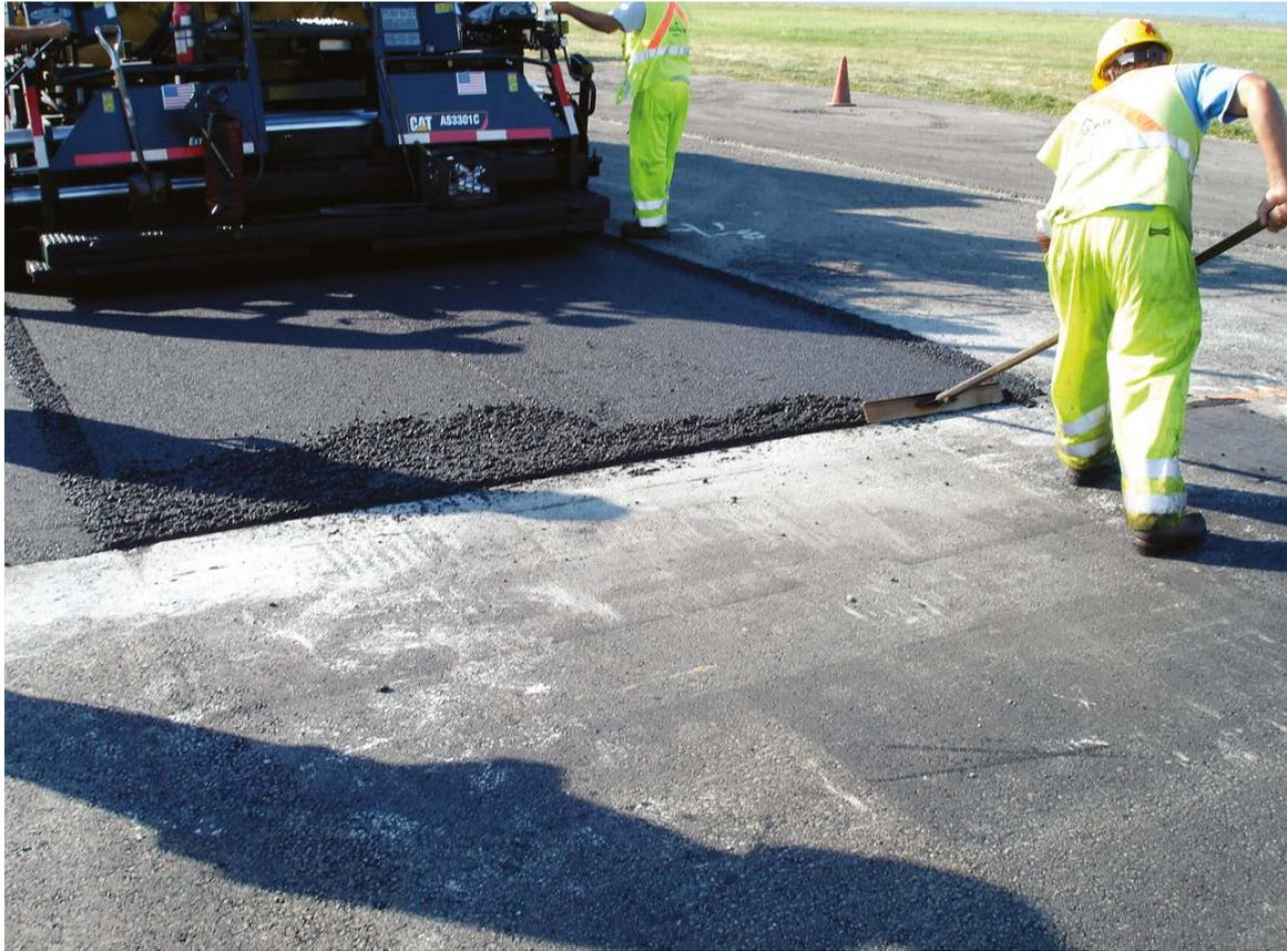
*Una junta plana construida correctamente requiere mínimas tareas manuales antes de la compactación.*
