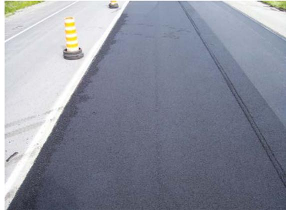
*Una curvatura principal insuficiente puede causar una franja en la línea central.*
