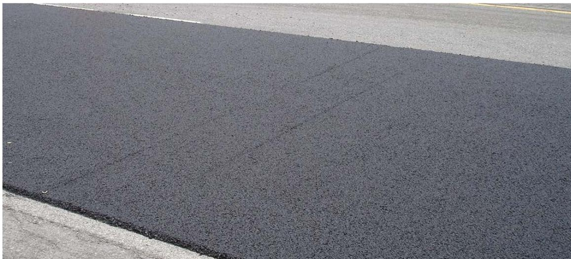
*Impresión de la regla en la capa bituminosa creada por la detención de la pavimentadora.*
