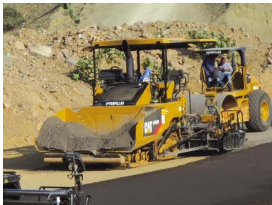
*El concreto compactado con rodillo puede ser trasladado a la pavimentadora por un camión volquete o por un camión mezclador de cemento.*
