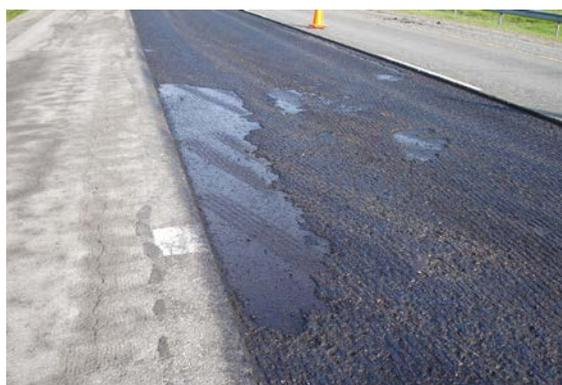
*Si la superficie fresada tiene áreas de delaminación, es posible que se deba ajustar la profundidad de fresado.*
