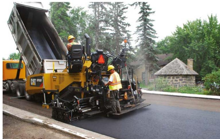
Las reglas de montaje frontal tienen extensores que se mueven hacia adentro y hacia afuera delante de la regla principal.
