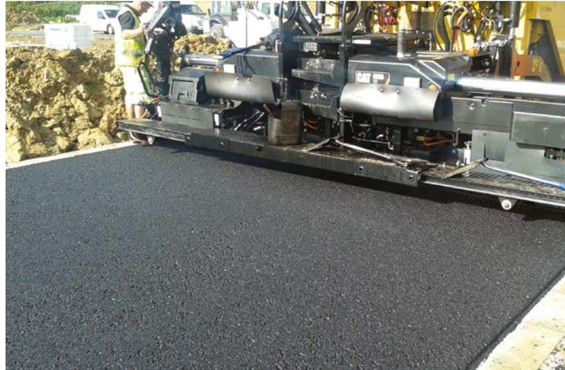
Las reglas extensible de montaje trasero tienen extensores que se mueven hacia adentro y hacia afuera detrás de la regla principal.
