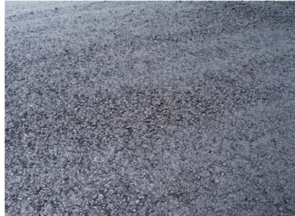
*Segregación en forma de manchas aleatorias causada por un bajo nivel de mezcla en la inserción de la tolva.*
