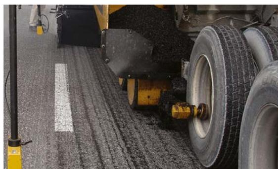
*Un enganche de camión ofrece una conexión positiva entre la unidad de transporte y la pavimentadora.*
