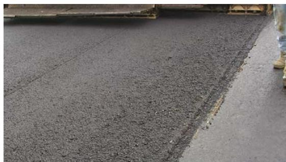
La pavimentación con control de nivelación longitudinal automático para corregir el perfil transversal creó una capa delgada de material en el borde derecho, lo que genera una producción incorrecta.
