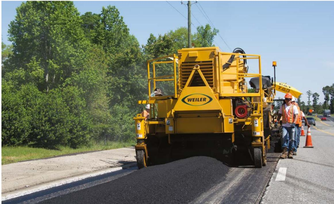
*Elevador de hilera de gran producción trasladando material a una pavimentadora con una pieza de la tolva.*
