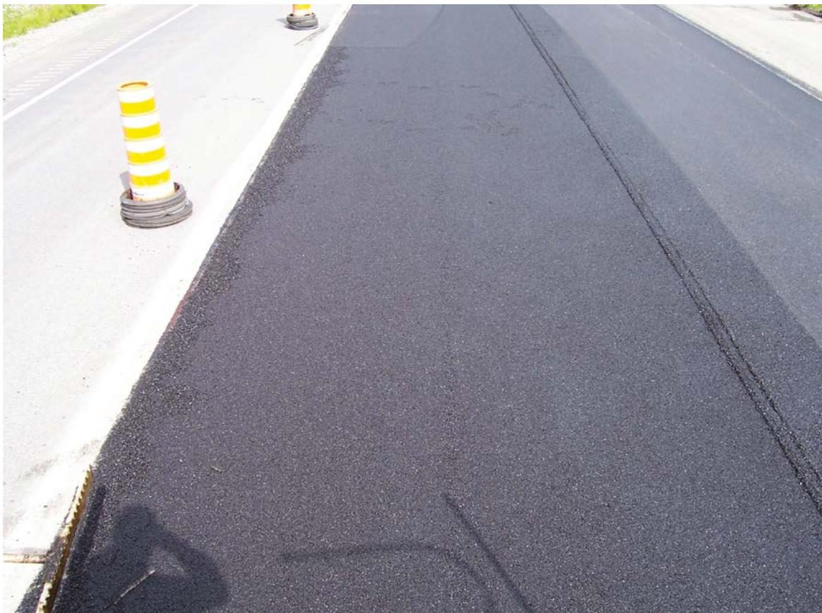
*Las franjas de la línea central se pueden relacionar con el funcionamiento del sistema de alimentación.*
