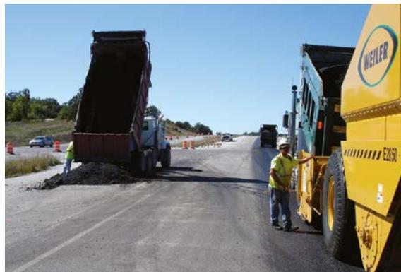
*En este proyecto, los conductores utilizan el carril de emergencia como área designada para la limpieza del vehículo. El material se recuperará al final del turno.*
