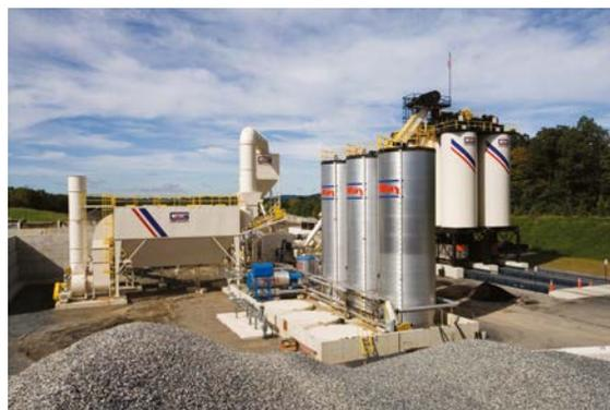
*Tanques de almacenamiento de cemento asfáltico.*
