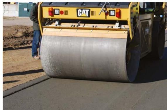
*Para evitar deformar el borde, manténgase a una distancia de 30 cm a 40 cm (12" a 15") del borde.*
