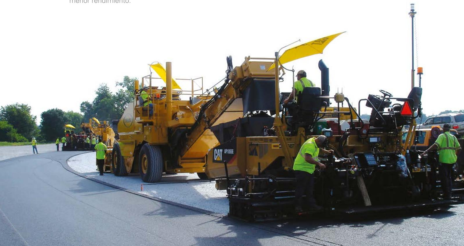
Prevea que se esté pavimentando la capa base en una carretera de 11,6 m (38') de ancho. La profundidad de pavimentación es de 75 mm (3"). Dos plantas de asfalto suministrarán al proyecto 400 toneladas métricas (440 toneladas) de asfalto por hora. El plano requiere que se utilicen tres pavimentadoras para el proyecto.
