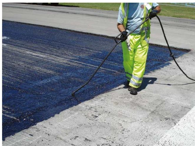
Use una varilla de rociado o un aplicador manual para aplicar el asfalto en la superficie de la junta plana.
