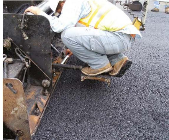
*El ángulo de ataque de las extensiones de la regla se debe ajustar mientras la pavimentadora está en movimiento.*
