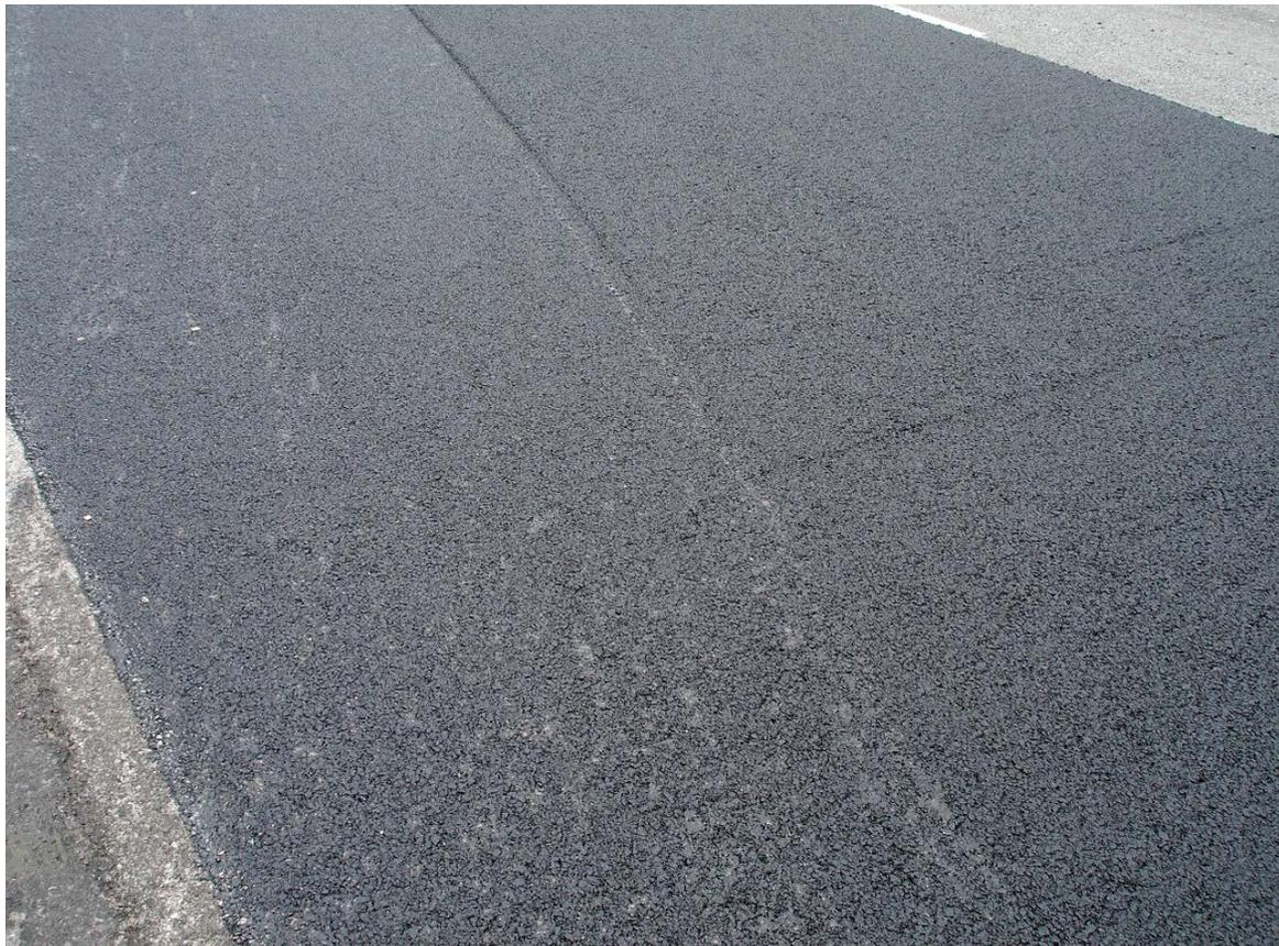
*Examine la superficie de la capa después de que el compactador de fase inicial haya completado una pasada sobre la hendidura de la regla.*
