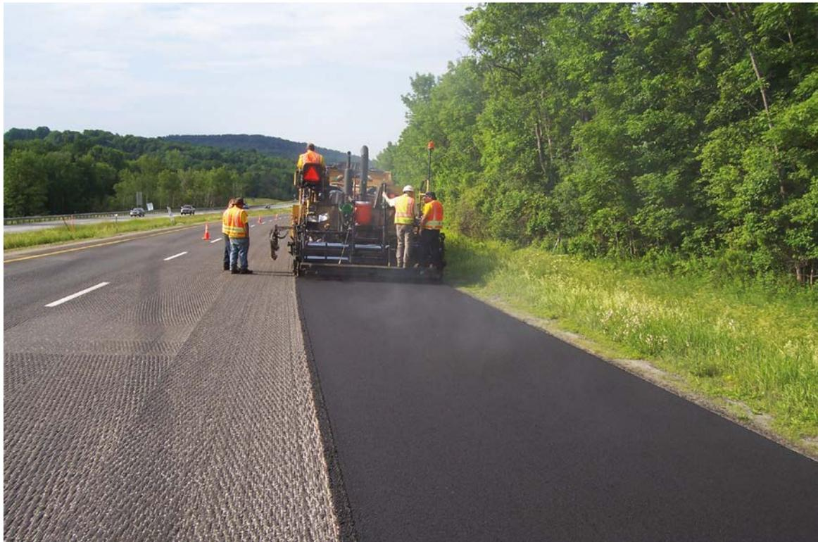
*Al pavimentar el carril de emergencia primero se proporciona una mejor referencia para el sistema de control de nivelación cuando se pavimenta el carril de conducción adyacente.*
