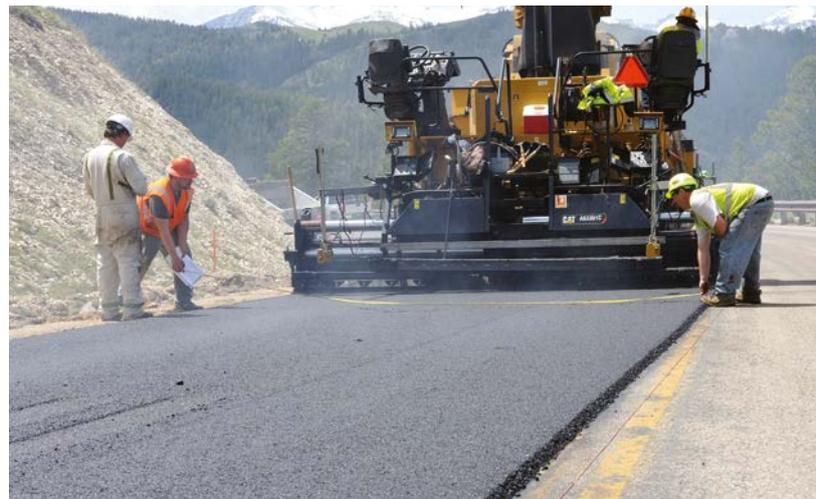
*Los extensores de regla izquierdo y derecho que se extienden hidráulicamente simplifican la tarea de cambiar el ancho de pavimentación.*
