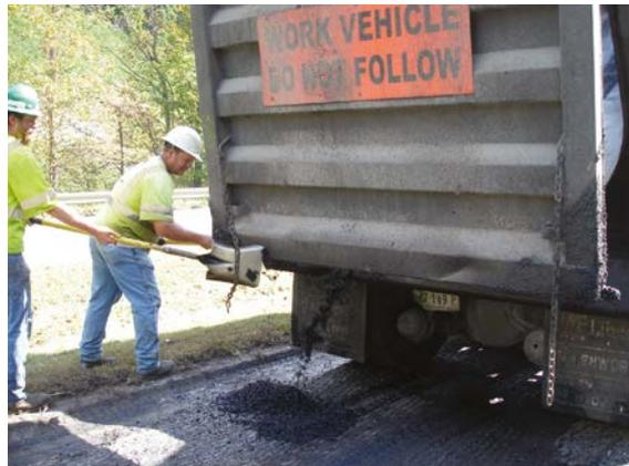
*La limpieza del camión no debe hacerse delante de la pavimentadora.*
