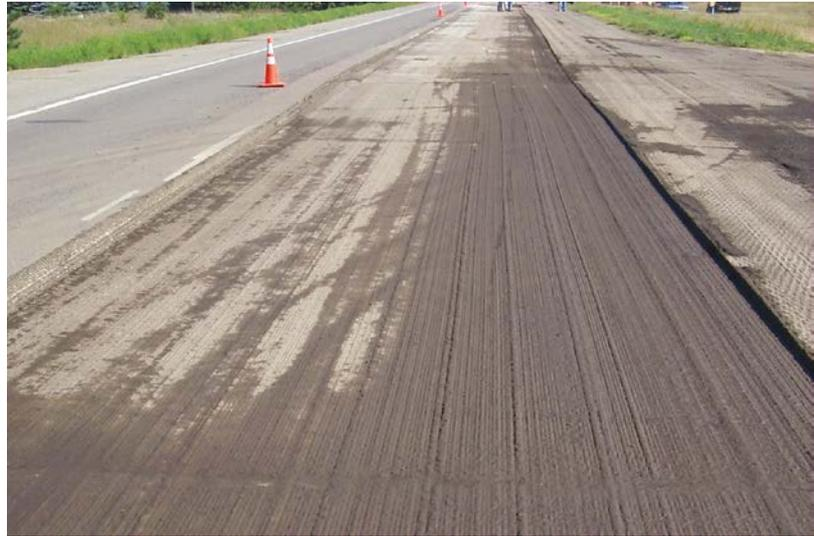
*Pavimentar sobre una zona elevada en la superficie creará diferencias de textura en la superficie de la capa de asfalto.*
