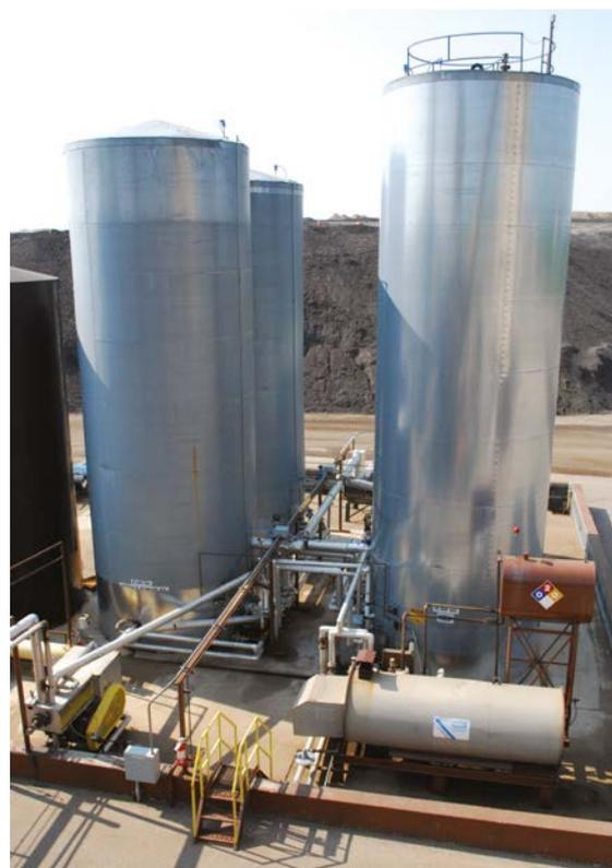
*El alquitrán calentado agregado a la mezcla permite que se forme el aglutinante necesario.*
