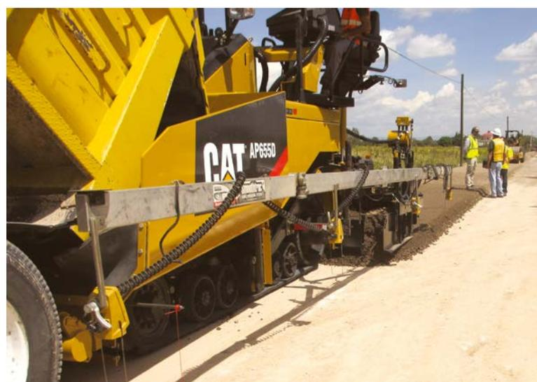
Un control de nivelación longitudinal y transversal convencional proporciona una profundidad precisa y un perfil transversal.
