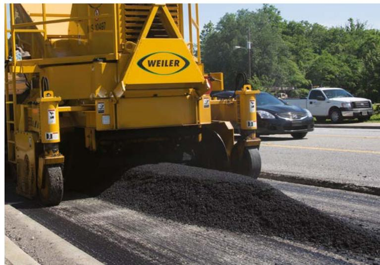
*El final de una hilera a menudo consta de agregados segregados.*
