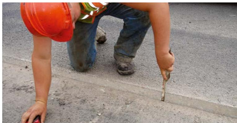
Mida la altura de la junta plana para ayudar a seleccionar el espesor correcto del tablero de inicio.
