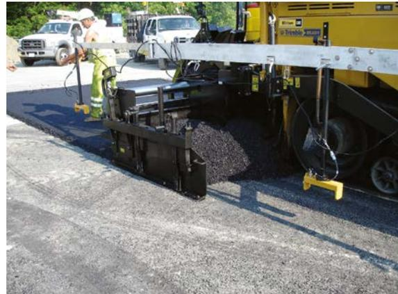
*El último sensor del patín sin contacto de Cat se configura para indicar la superficie de la capa directamente detrás de la regla.*
