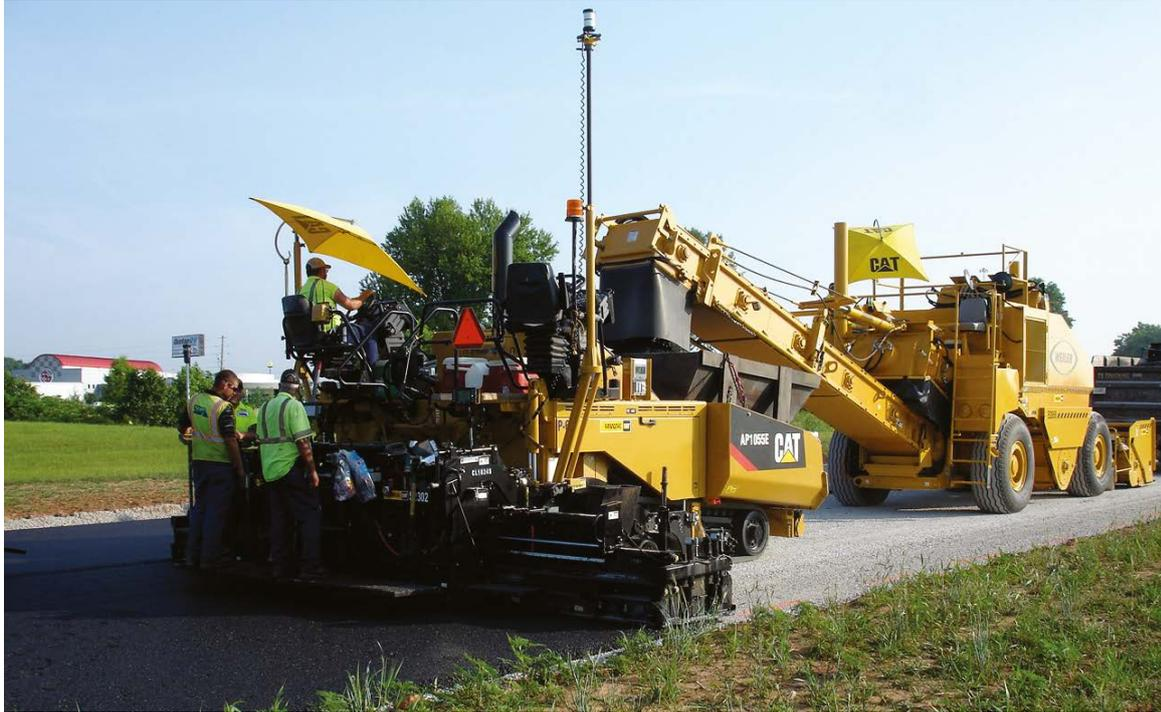
*Pavimentadora de Cat equipada con sistema de guía tridimensional de Trimble.*
