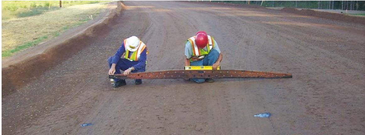
*La verificación del perfil transversal antes de la pavimentación ayuda al personal a comprender cómo configurar la pavimentadora.*
