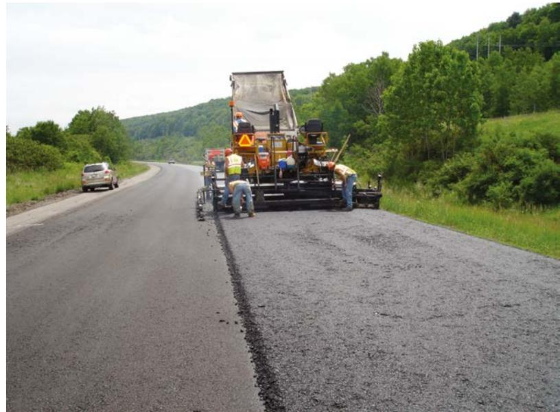
*La segregación de final de carga aparece en intervalos regulares como manchas o formas en V en la capa de asfalto.*
