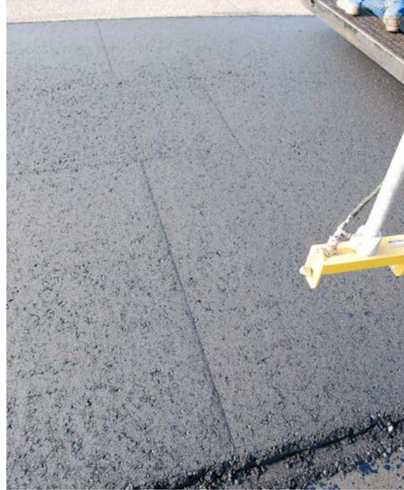
*Cuando la pavimentadora se detiene sobre el material bituminoso fresco, puede dejar una impresión de la regla en la superficie de la capa.*
