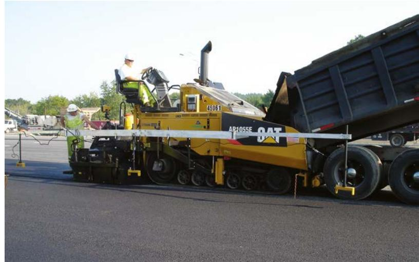
*Patín promediador sin contacto de Cat instalado para indicar la nivelación fuera del ancho de pavimentación.*
