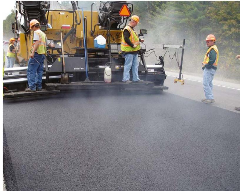
**Capa niveladora:** en algunos proyectos, especialmente los proyectos de fresado en frío y repavimentación, se puede instalar una capa niveladora, también denominada capa de relleno antes de la capa superficial. El objetivo de la capa niveladora es corregir el perfil transversal (inclinación transversal) y ayudar a mejorar el perfil longitudinal (homogeneidad). Una capa niveladora tiene generalmente 5 cm (2") de espesor como máximo.
