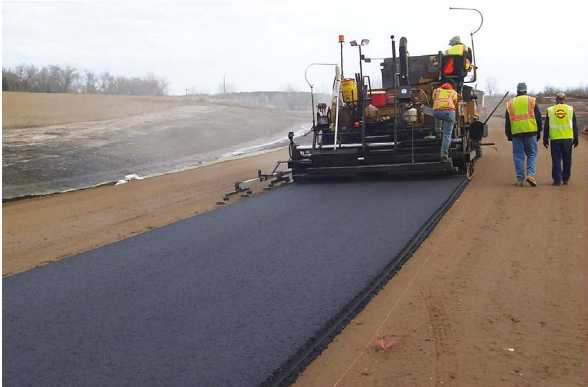
*Pavimentación de superelevación con patín promediador a la izquierda, inclinación transversal a la derecha.*
