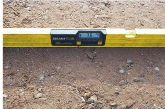
El medidor de nivelación transversal electrónico que muestra una inclinación transversal del 3,6 por ciento de derecha a izquierda junto a donde la estaca de nivelación de la página 221 muestra el 4 por ciento requerido.
