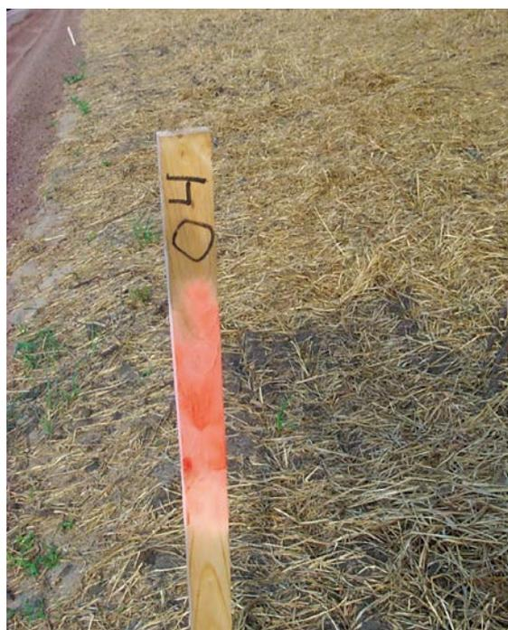
*Estaca de nivelación que indica la inclinación transversal en un punto de la desviación de la superelevación.*
