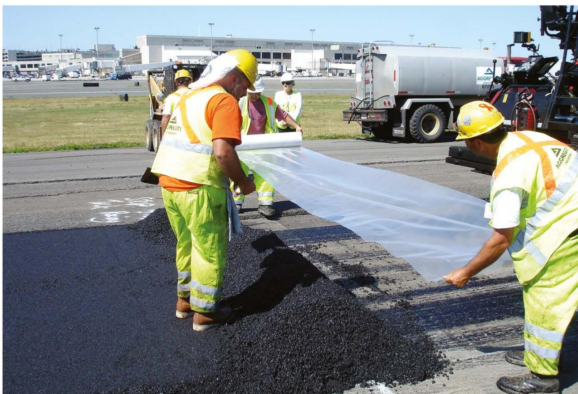
*El final de una pasada se debe preparar, de manera que crear una junta plana sea fácil cuando se termina la pavimentación.*
