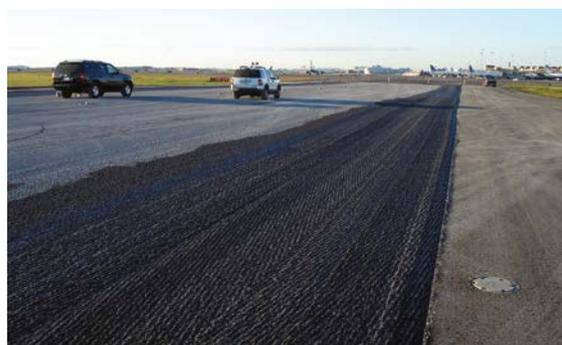
Se debe aplicar asfalto o adhesivo en la cara de la junta, además de la base antes de la pavimentación.
