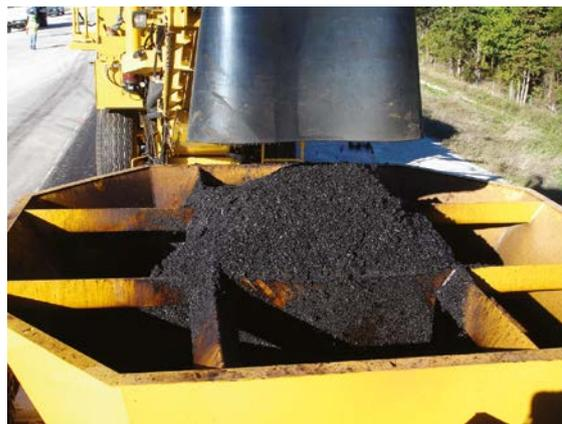
*Nunca use todo el material de la pieza de la tolva o el vehículo de traslado cuando paviemente.*
