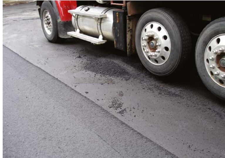
*Los derrames delante de la pavimentadora pueden causar zonas elevadas en la superficie.*
