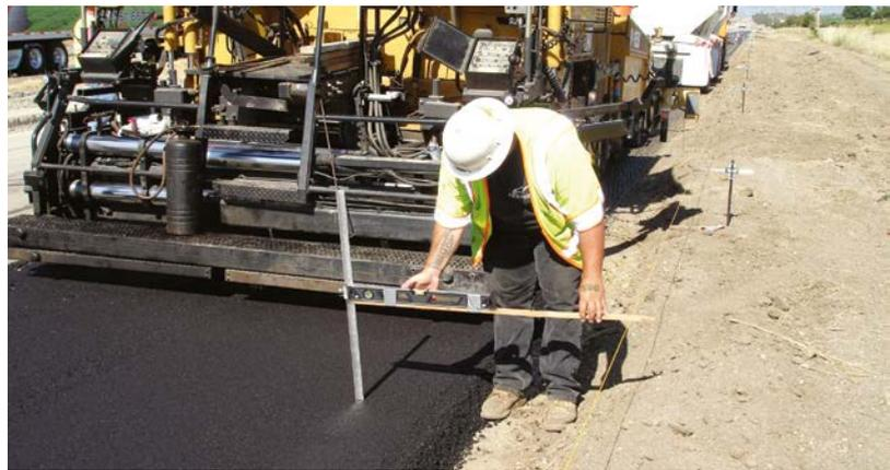
*Control de la elevación de una capa base con una línea de referencia instalada en la construcción de una carretera nueva.*
