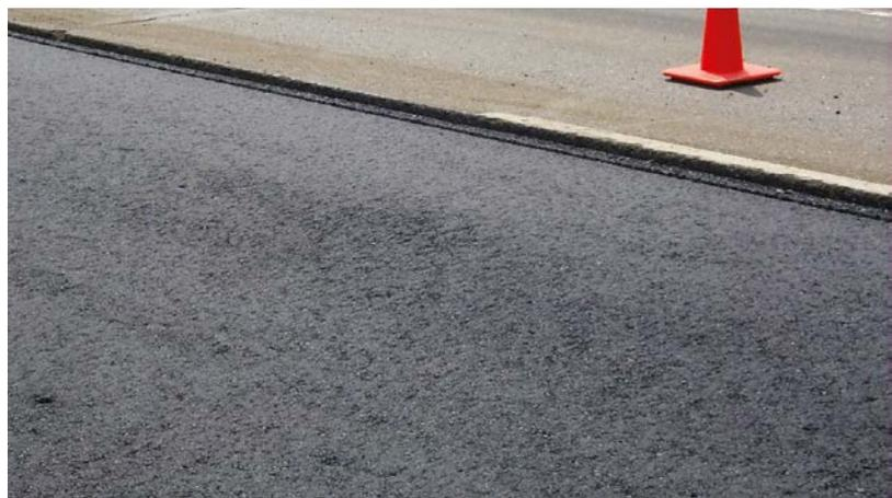
*Franjas de textura temporales causadas por la pavimentación sobre zonas elevadas en superficies fresadas.*
