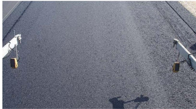
*Las franjas texturadas en la superficie de la capa bituminosa generalmente son ocasionadas por las variaciones en el ángulo de ataque a través del ancho de la regla.*
