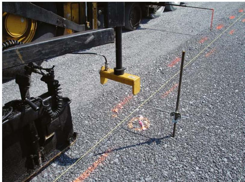
*Sensor de nivelación longitudinal de Cat en orientación de la línea de referencia.*
