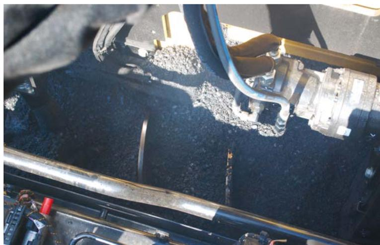
*El operador de la pavimentadora verifica el nivel de cabeza de material del centro de la cámara del sinfín.*
