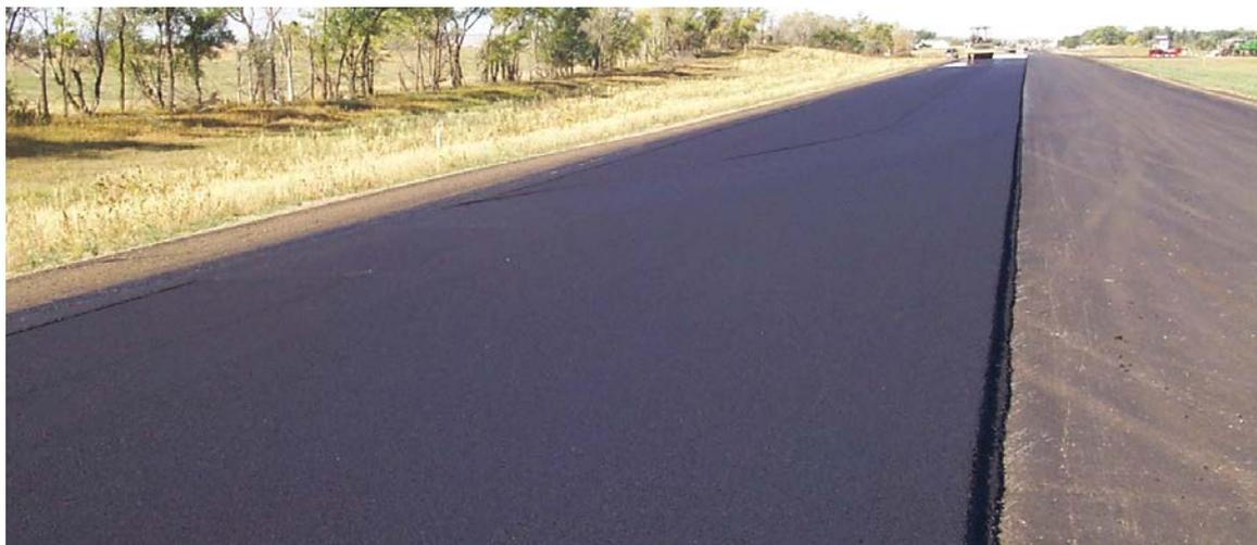
La creación de un borde recto para la unión es el primer paso en la construcción de juntas longitudinales.
