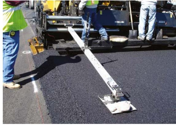
La sección trasera del nivelador Fore 'N Aft pasa sobre la nueva capa bituminosa.
