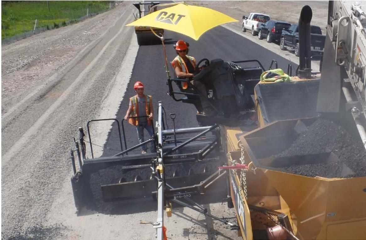
*Solicite las extensiones necesarias para reglas, sinfines y bastidores principales cuando se prepare para una pavimentación de gran anchura.*
