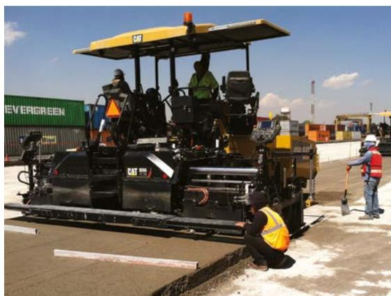
*Generalmente las capas gruesas de concreto compactado con rodillo se aplican con reglas combinadas.*
