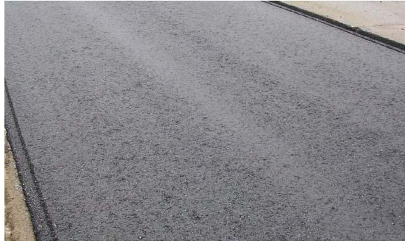
*Un funcionamiento con los sinfines muy bajos puede causar dos áreas de textura abierta directamente detrás de los ejes del sinfín.*
