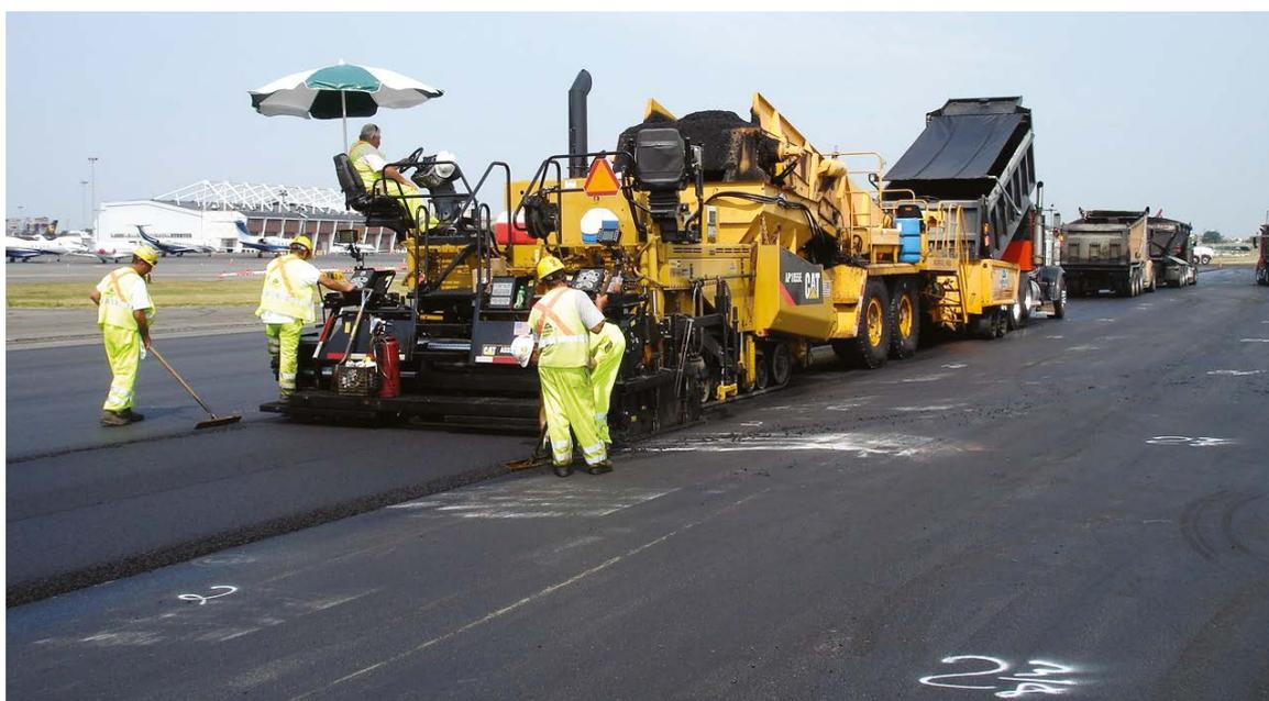
Un equipo de sondeo puede marcar elevaciones directamente en el suelo en un diseño de cuadrícula.
