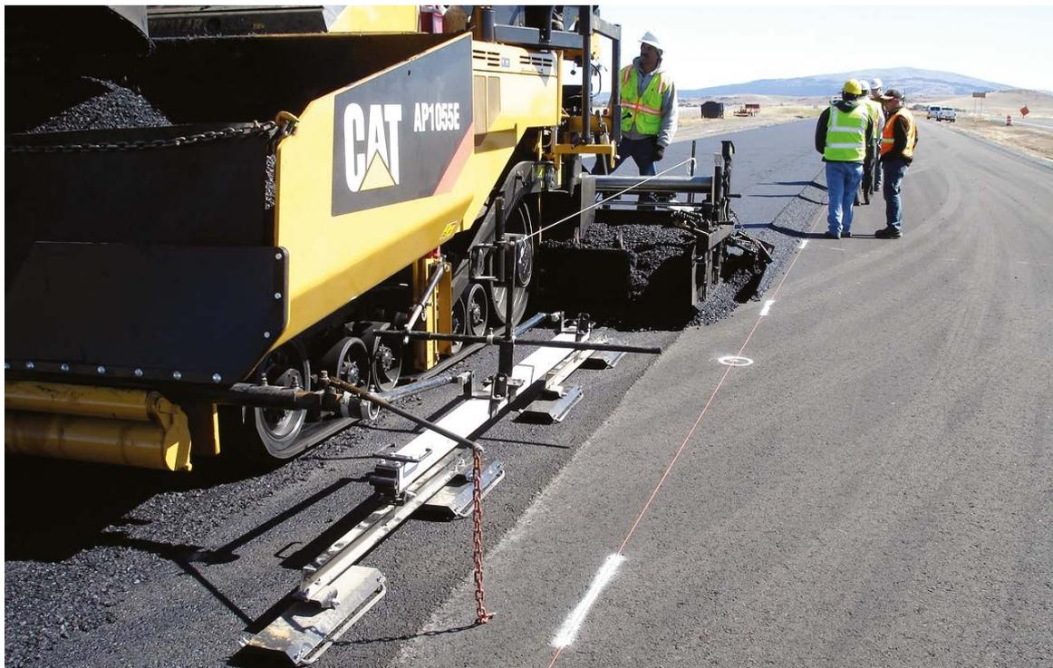
*El nivelador Fore 'N Aft de 9 metros (30') proporciona una capacidad promediadora dentro del ancho de pavimentación.*
