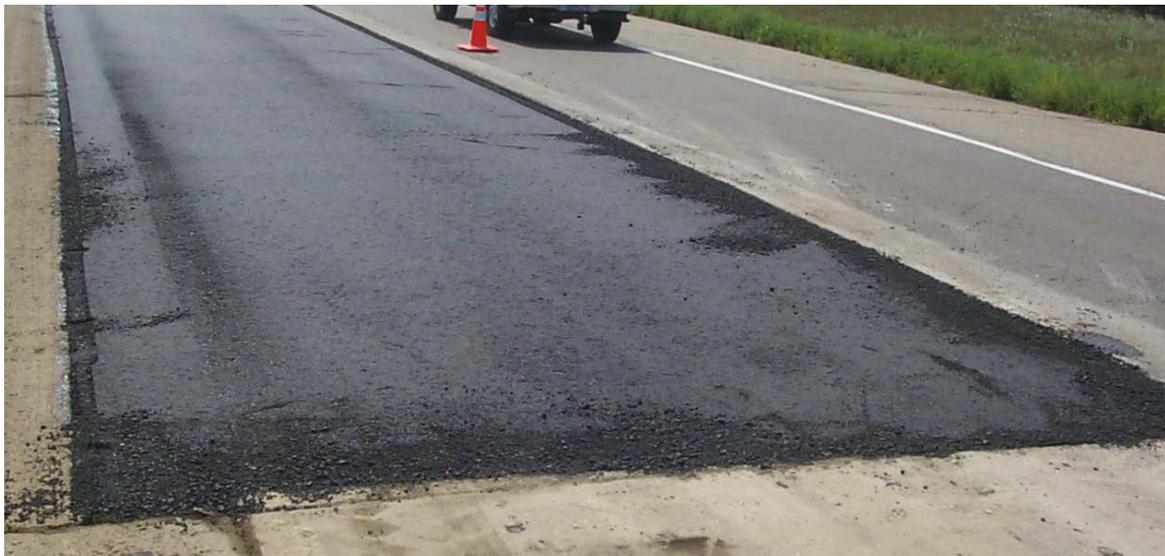
*Una placa que no está calentada adecuadamente o que tiene secciones frías creará marcas de arrastre y franjas de textura.*
