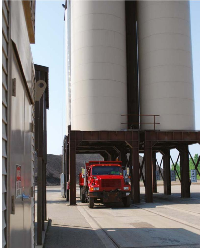
*Los depósitos de compensación y almacenamiento ayudan a garantizar el flujo ininterrumpido del material al lugar de trabajo.*
