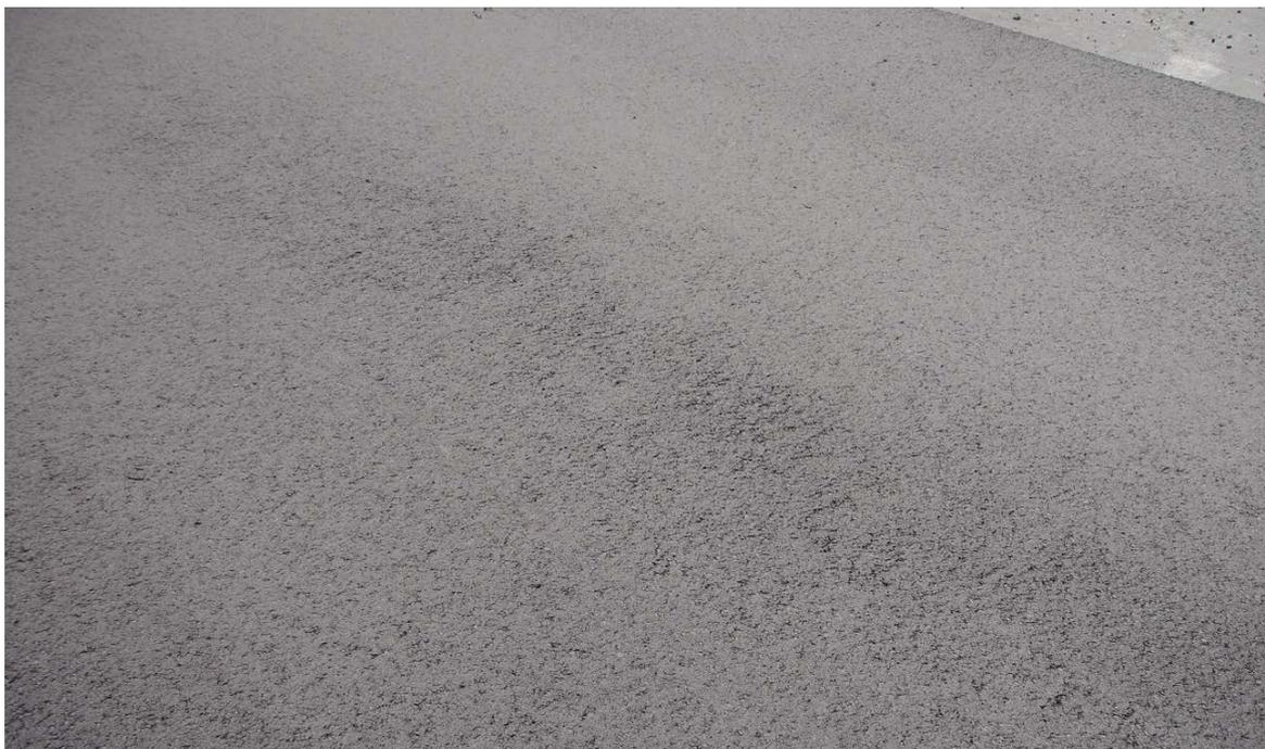
*Marca de arrastre causada por la pavimentación sobre un derrame compactado.*
