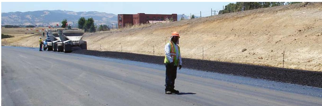
*Cuando las condiciones de la temperatura ambiente lo permitan, puede haber una hilera larga delante de la pavimentadora.*
