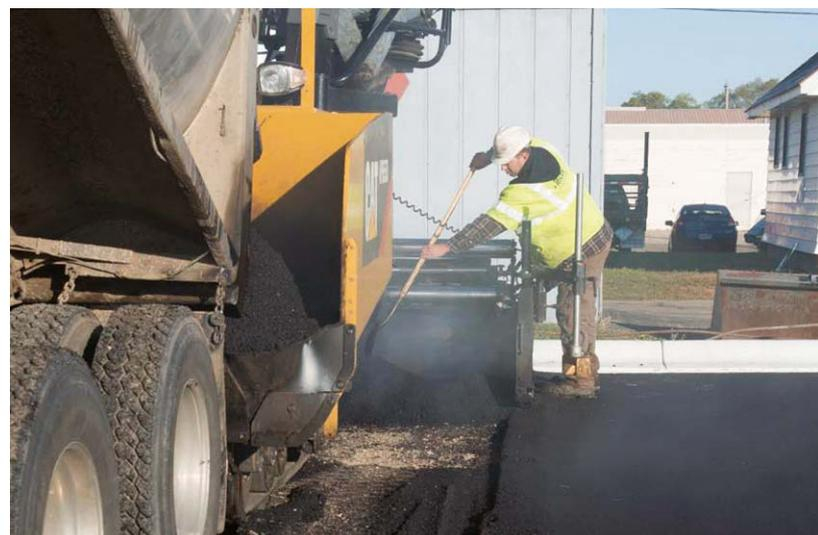
Utilice una pala para sacar el material por la compuerta lateral.
