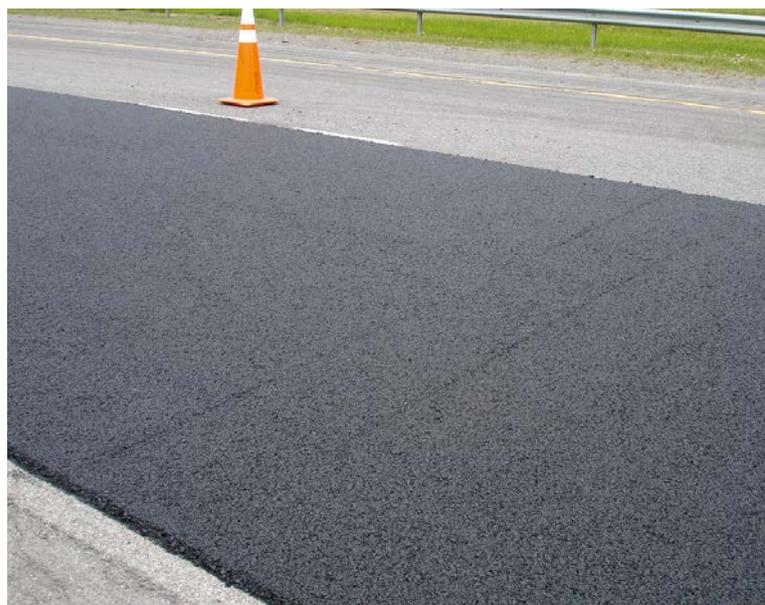
La detención de la pavimentadora durante los intercambios de camión puede producir una marca de asentamiento de la regla.
